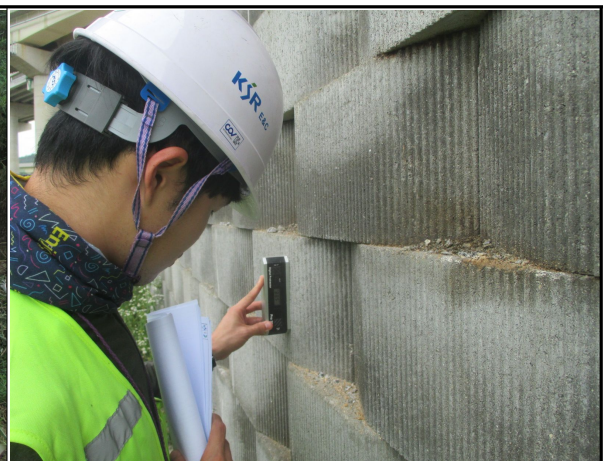
STA.4+810~5+012 옹벽 기울기 측정
