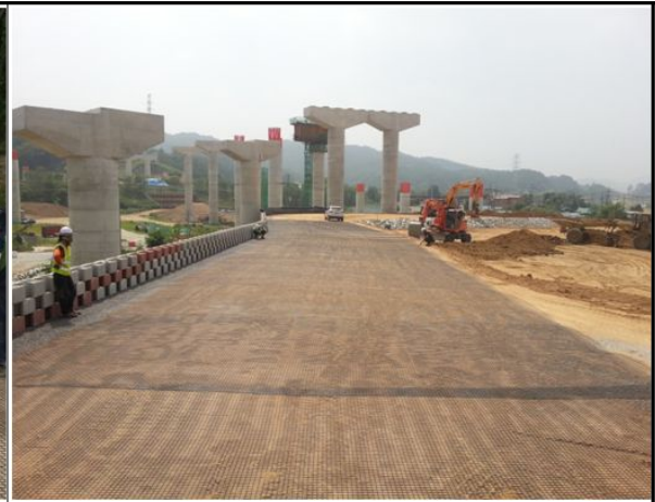
STA.4+810~5+012 그라드 길이 측정
