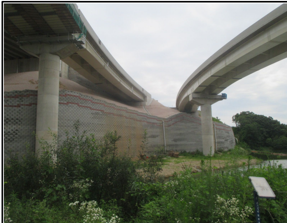
STA.4+810~5+012 옹벽 시공 전경
