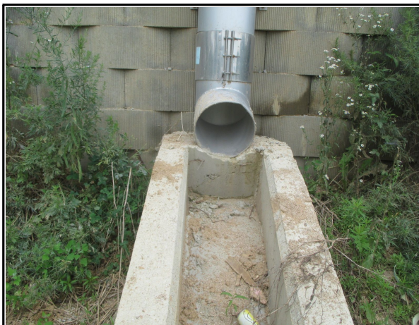
STA.4+810~5+012 옹벽 배수시설 설치 상태
