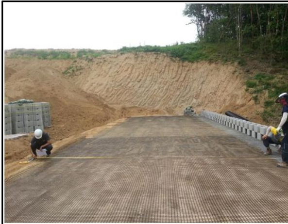
STA.4+810~5+012 그라드 길이 측정
